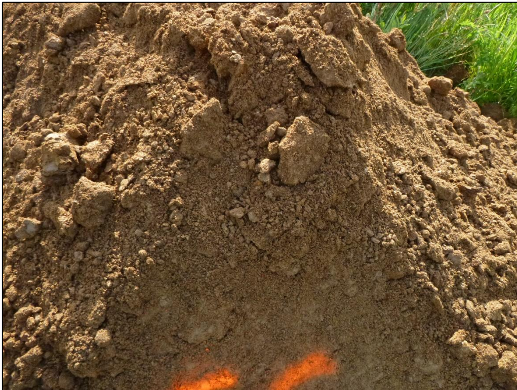
Déblais de F6
