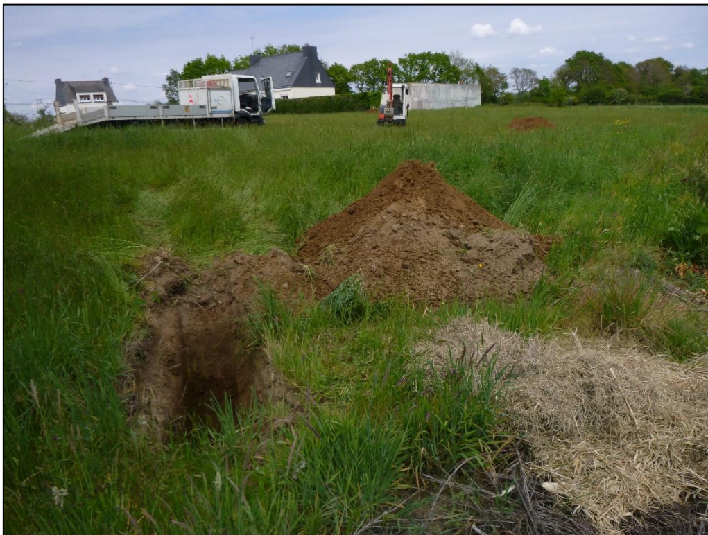
Déblais de F1
