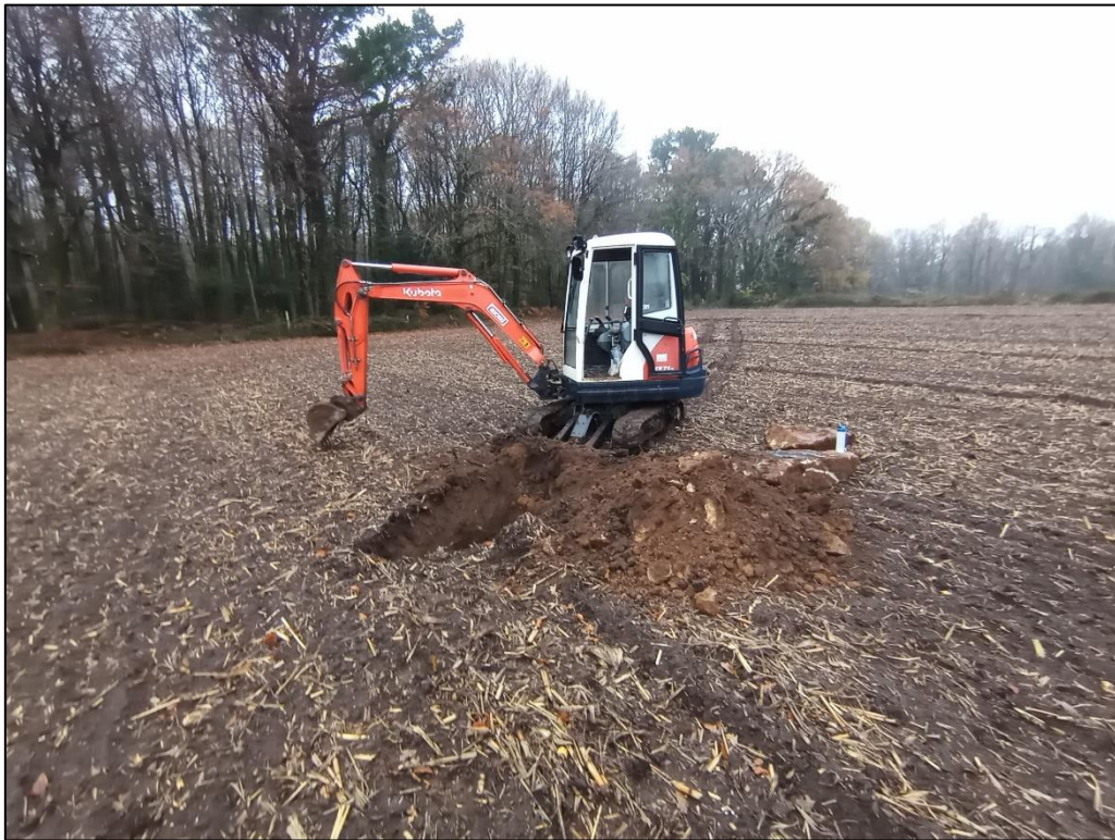
Déblais de F3
