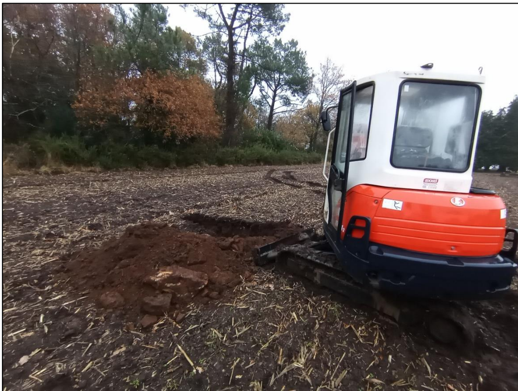
Déblais de F1
