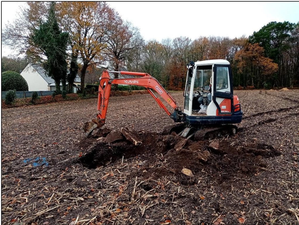
Déblais de F4
