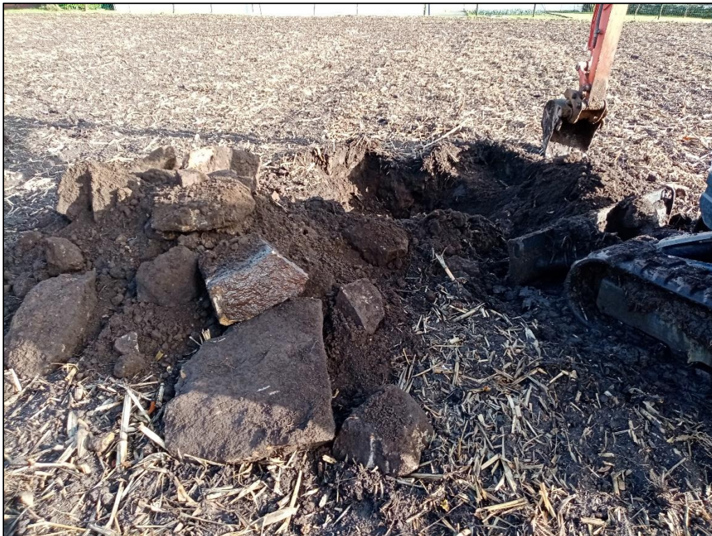
Déblais de F9
