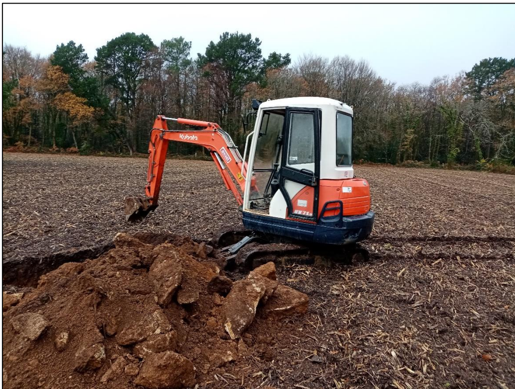
Déblais de F6
