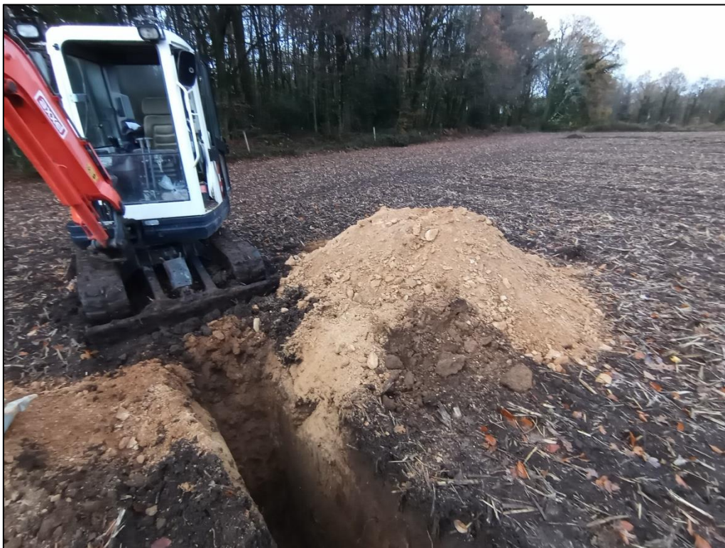
Déblais de F8
