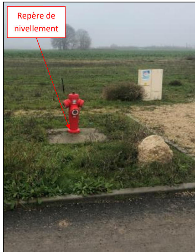
Photo du repère de nivellement
