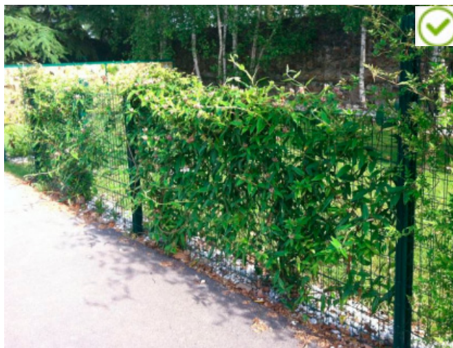
Clôture treillis soudés avec plantes grimpantes
