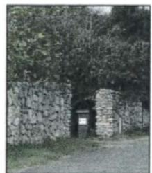
Mise en place d'un muret technique au droit des accès aux lots - parement en pierre
